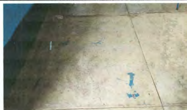
Foto 3: Sustitución de piso deteriorado, por piso cerámico del aula de preprimaria.
