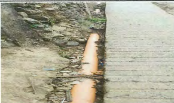
Foto 6: Sustitución de sistema de tubería de aguas residuales del centro educativo.
